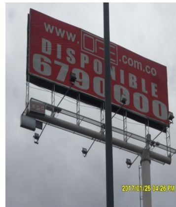
SENTIDO SUR- NORTE DE LA VALLA TUBULAR
