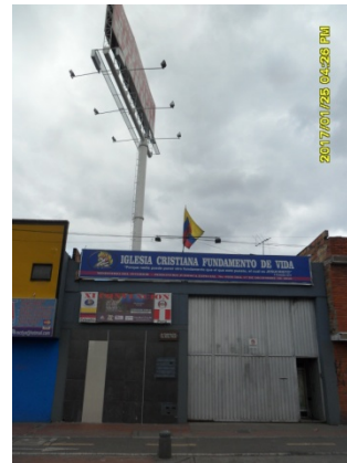
FACHADA DEL PREDIO
